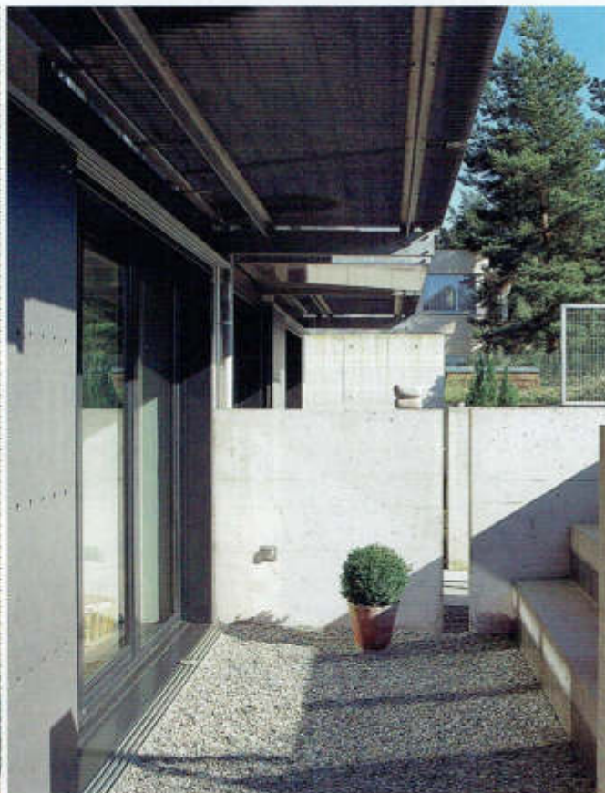
Die Trennwand beim Eingang gewährt Privatsphäre, ohne Kontakte zu behindern. rechts
