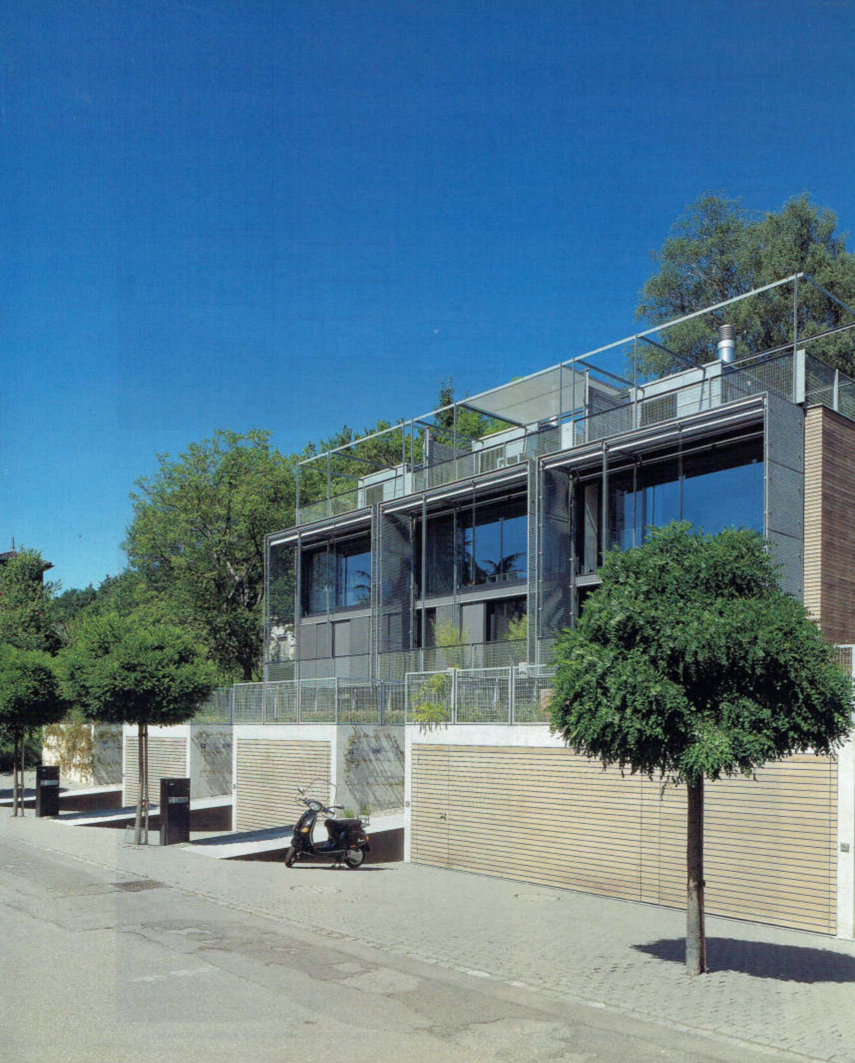
Filigrane Vorbauten aus Stahl grenzen die drei Reihenhäuser optisch voneinander ab.
